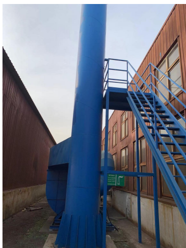
DA023 采样平台
